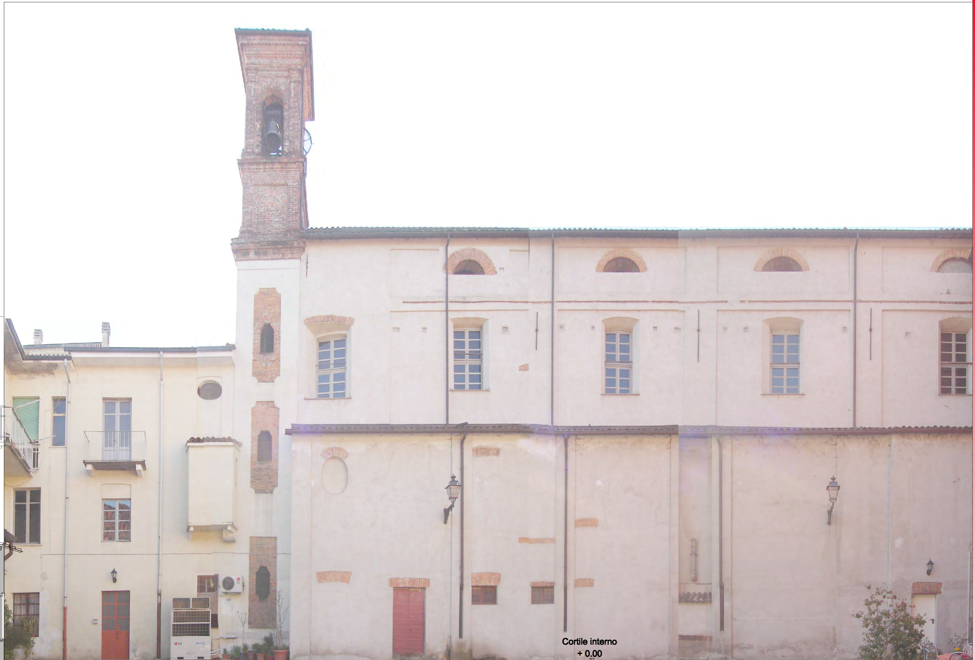
SEZIONE MANICA LUNGA E PROSPETTO DELLA CHIESA VERSO IL CORTILE (PROSPETTO NORD) FOTORADDRIZZATO CON SOFTWARE PHOTOSHOP . SCALA 1:100
