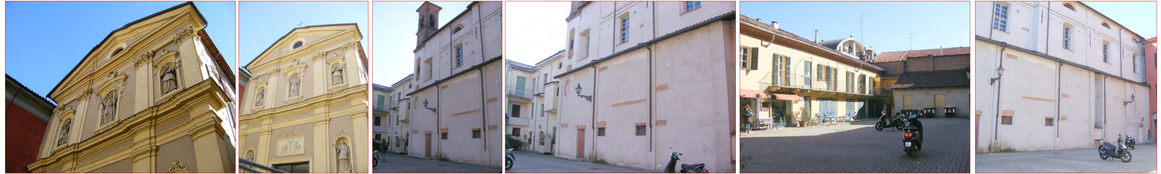
Immagini scattate durante uno dei sopralluoghi in situ. Si osserva la facciata principale della chiesa, il cortile interno della chiesa.
