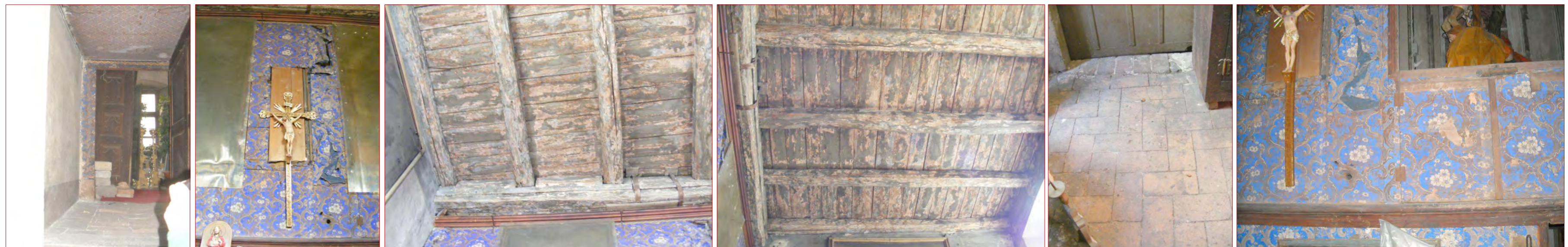
Immagini scattate durante uno dei sopralluoghi in situ. Si osservano alcune foto del vano al primo piano, sopra la sacrestia; si nota il cassettonato originale a copertura del vano e la pavimentazione dello stesso.
